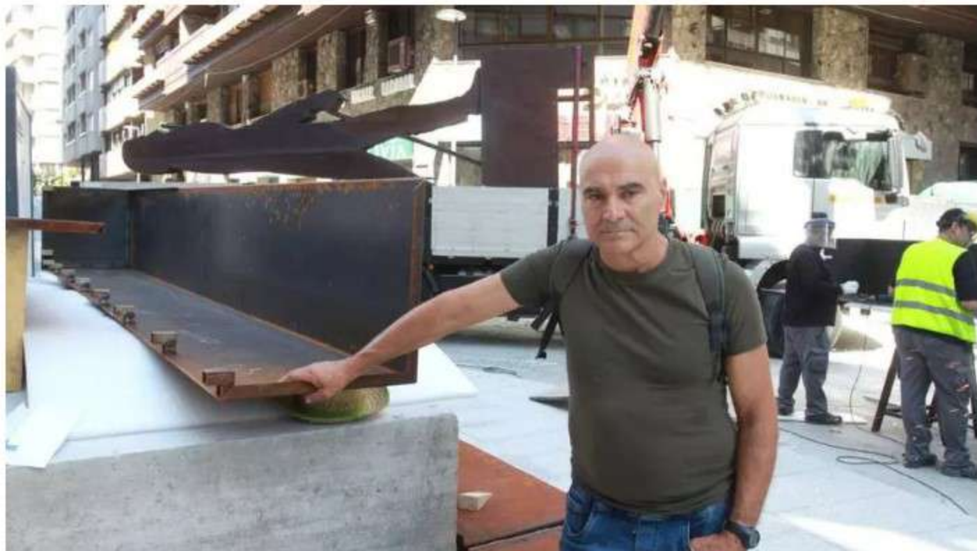
Ramón Conde supervisa la reinstalación de su obra Los Ramones. | IÑAKI OSORIO / S. DE LA FUENTE
